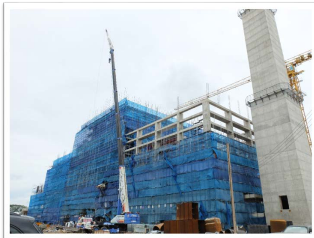
การก่อสร้างระบบเตาเผาขยะมูลฝอย ณ ศูนย์จัดการขยะมูลฝอยหนองแขม
