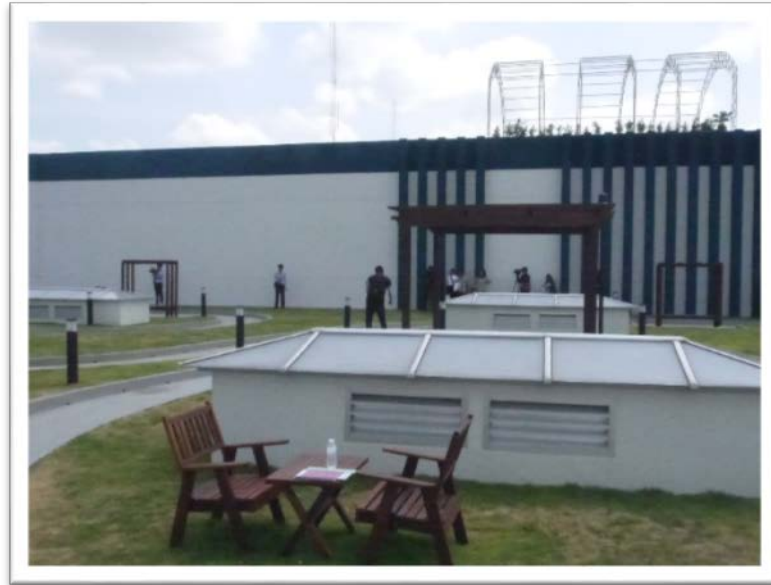
ระบบการระบายความร้อน บนดาดฟ้าของตัวอาคาร
