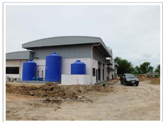
อาคารบำบัดน้ำเสียแบบ MBR และ RO
