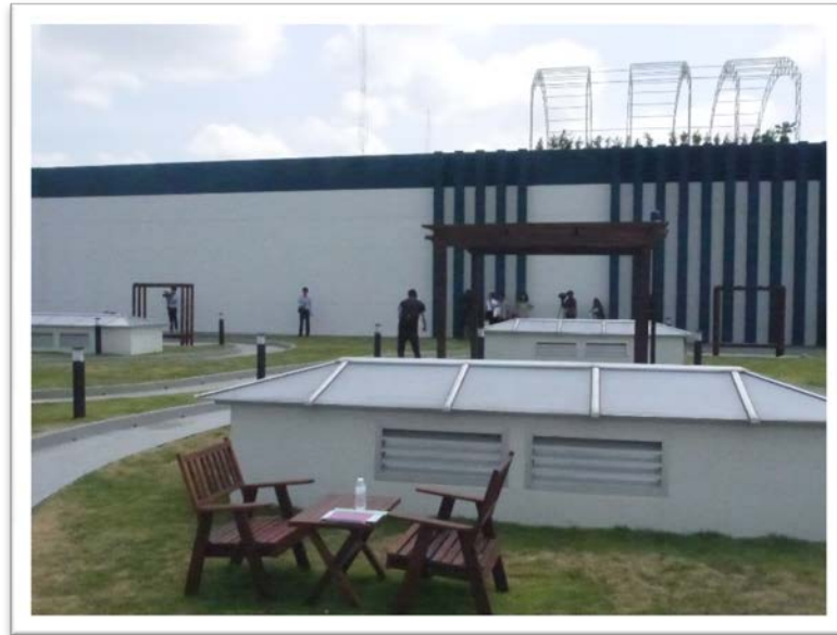
ภาพที่ 12 แสดงระบบการระบายความร้อน บนดาดฟ้าของตัวอาคาร
