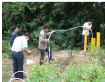
ภาพที่ ๗ การประเมินสถานที่กำจัดขยะมูลฝอย และเก็บตัวอย่างคุณภาพน้ำใต้ดิน ณ สถานที่กำจัดขยะมูลฝอยขององค์กรปกครองส่วนท้องถิ่น
