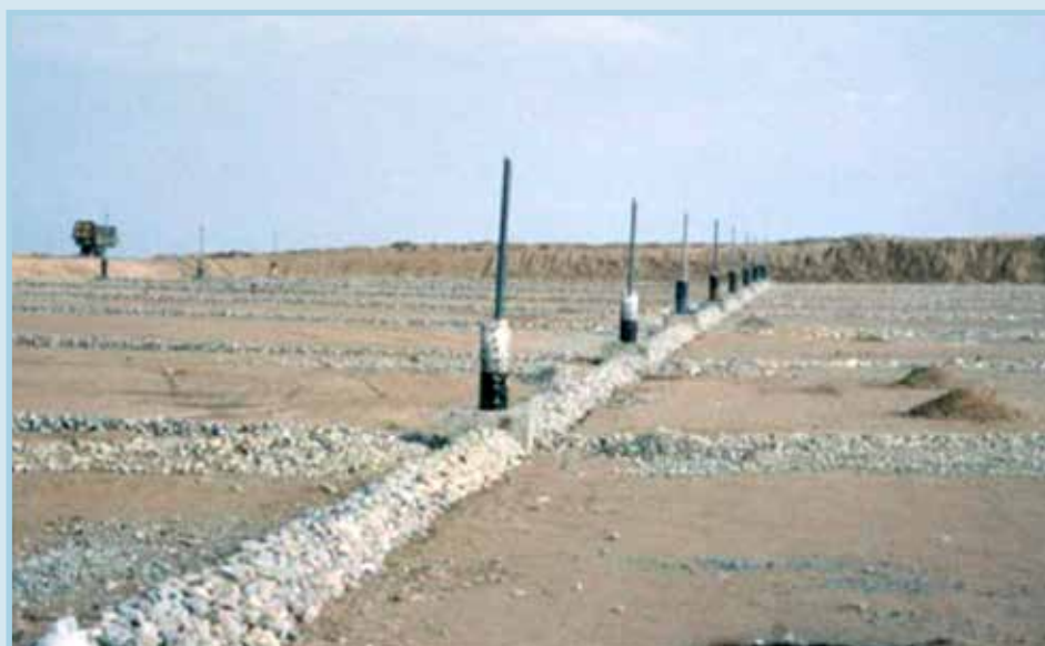
รูปที่ 18 การติดตั้งท่อระบายก๊าซในบ่อฝังกลบขยะ
