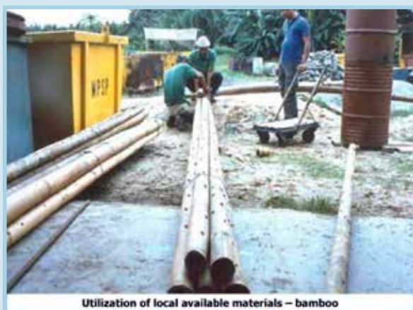
รูปที่ 26 การประยุกต์ใช้ท่อนไม้ไผ่เพื่อเป็นท่อบรรณน้ำชะขยะ (ตัวอย่างของประเทศมาเลเซีย)
