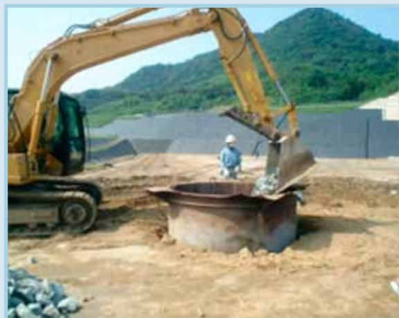
รูปที่ 73 รูปแบบการก่อสร้างระบบท่อระบายก๊าซ
