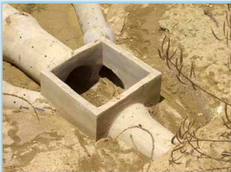
รูปที่ 46 การก่อสร้างบ่อพักเป็นจุดเชื่อมต่อของท่อรวบรวมน้ำชะขยะ
