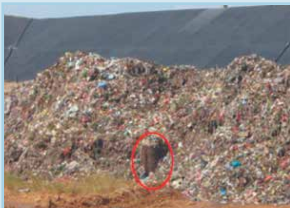
รูปที่ 68 ตัวอย่างที่ไม่ถูกต้องเนื่องจากความสูงของขยะมากกว่าความสูงของท่อระบายก๊าซ
