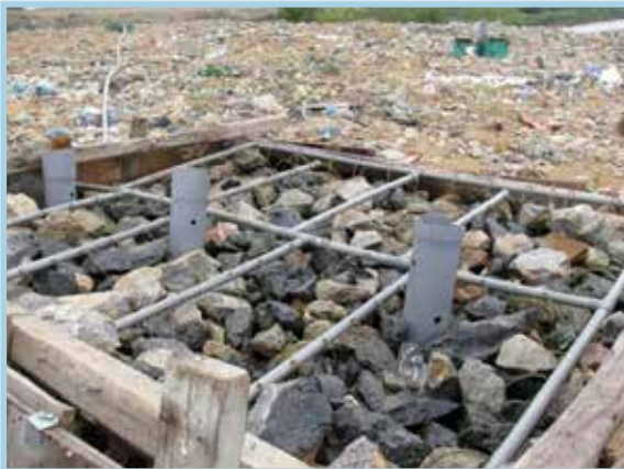
รูปที่ 59 การก่อสร้างระบบเวียนน้ำชะขยะเพื่อนำมาบำบัดในบริเวณบ่อฝังกลบขยะ
