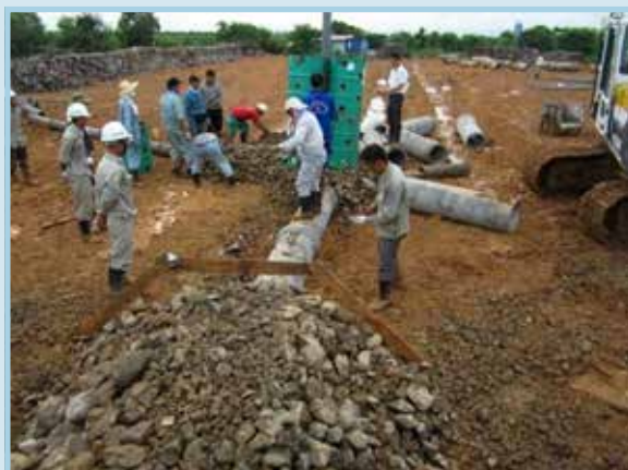
รูปที่ 43 การเกลี่ยหินบดย่อยให้เป็นลักษณะสี่เหลี่ยมคางหมูโดยแรงงานคน
