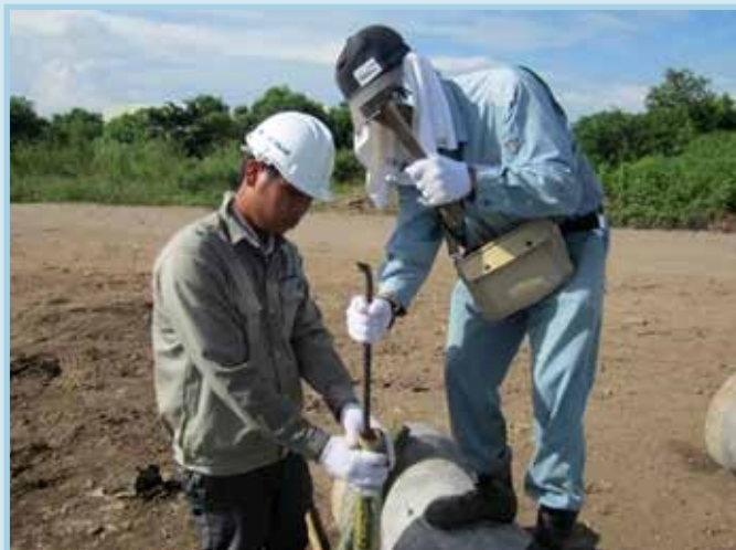
รูปที่ 49 การเจาะข้อไม้ไผ่เพื่อให้น้ำชะขยะไหลได้อย่างสะดวก
