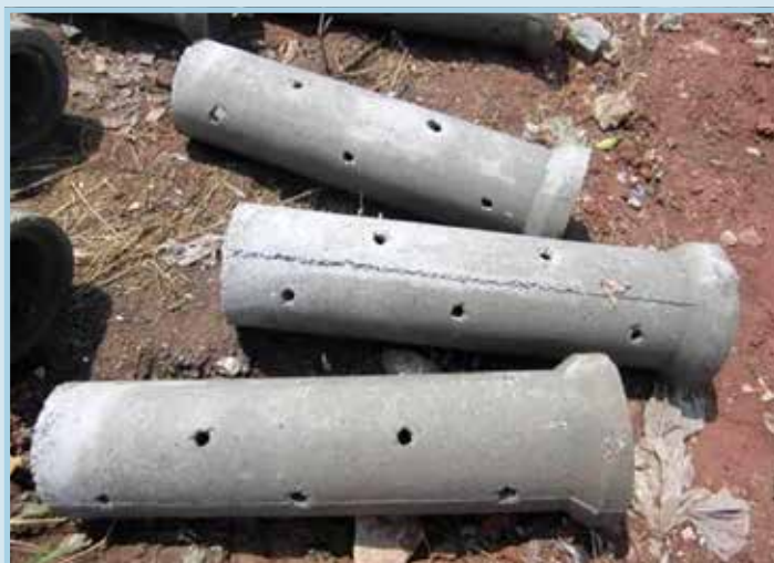
รูปที่ 30 การเจาะรูท่อรวมน้ำชะขยะ
