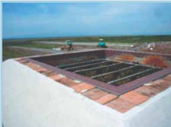
รูปที่ 25 ตัวอย่างการออกแบบระบบเวียนน้ำชะขยะกลับไปยังบ่อฝังกลบแห่งหนึ่งของประเทศญี่ปุ่น
