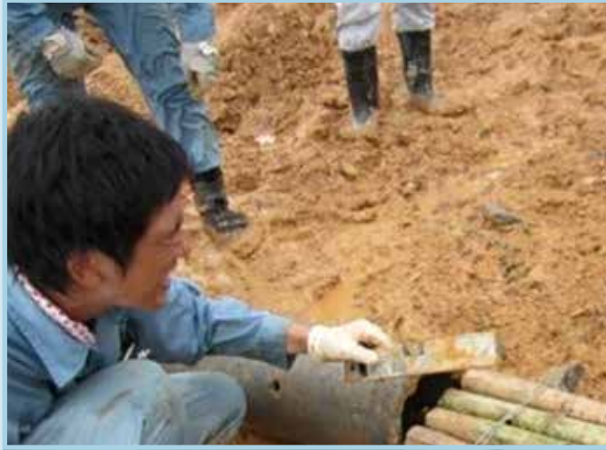
รูปที่ 51 การเชื่อมต่อท่อไม้ไผ่ลงในท่อซีเมนต์ที่ชำรุดเสียหาย
