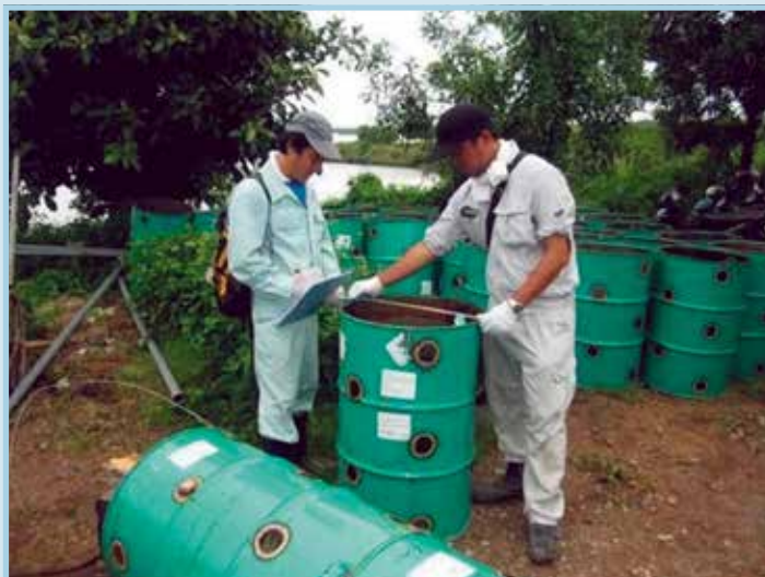
รูปที่ 34 การเตรียมท่อปลอกเพื่อกรูท่อระบายก๊าซโดยใช้ถังน้ำมันเก่าเจาะรู
