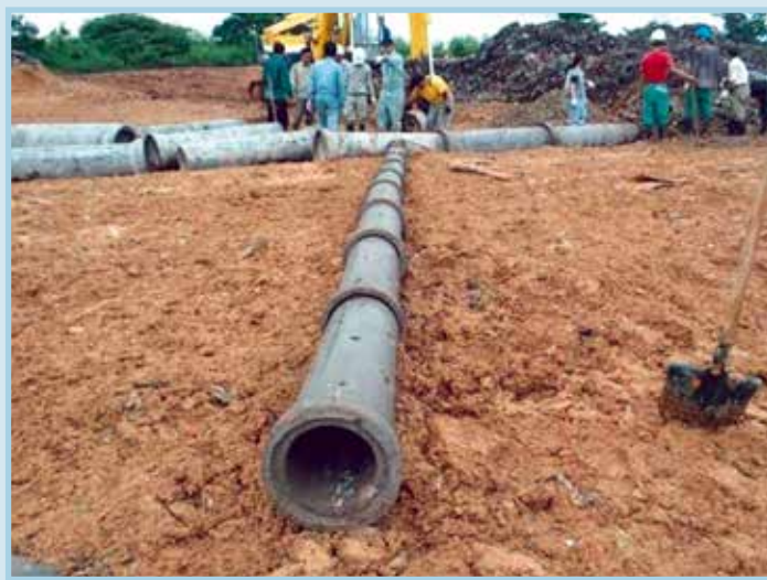
รูปที่ 41 การติดตั้งท่อแขนงเพื่อเชื่อมต่อกับท่อรวบรวมน้ำชะขยะสายหลัก
