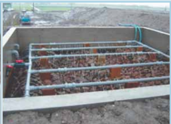
รูปที่ 25 ตัวอย่างการออกแบบระบบเวียนน้ำชะขยะกลับไปยังบ่อฝังกลบแห่งหนึ่งของประเทศญี่ปุ่น
