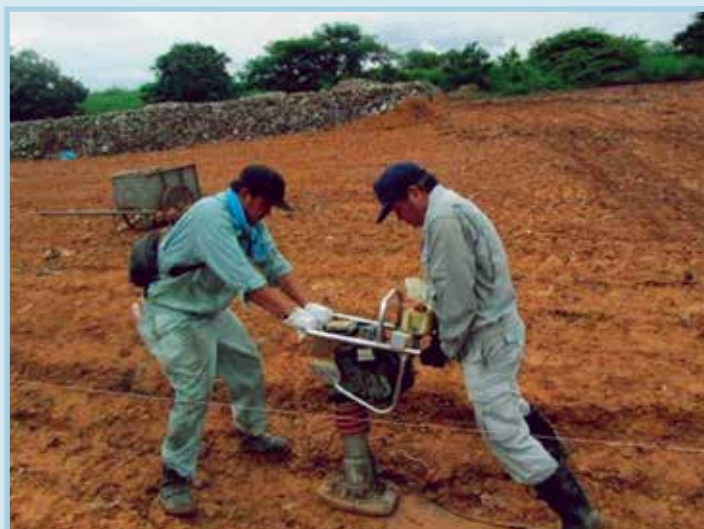
รูปที่ 36 การบดอัดดินชั้นล่างให้แน่นโดยใช้เครื่องตบดิน
