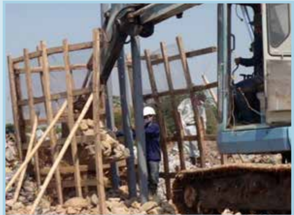
รูปที่ 59 การก่อสร้างระบบเวียนน้ำชะขยะเพื่อนำมาบำบัดในบริเวณบ่อฝังกลบขยะ
