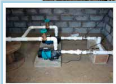
รูปที่ 80 ตัวอย่างของบ่อสูบน้ำชะขยะกลับไปบำบัดยังบ่อฝังกลบแห่งหนึ่งในเกาะชามัว
