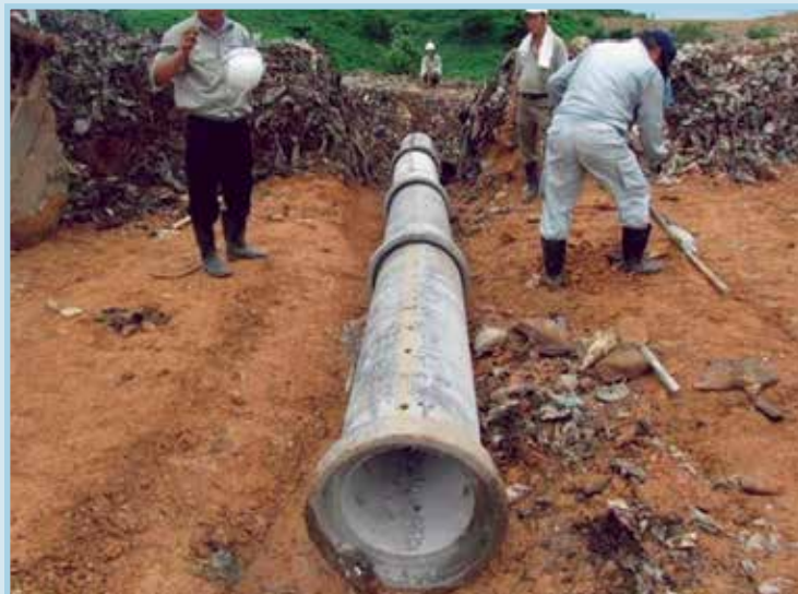
รูปที่ 37 การอัดดินชั้นล่าง เซาะร่อง เพื่อวางท่อรวบรวมน้ำชะขยะ
