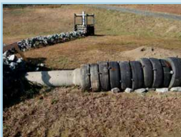
รูปที่ 27 ตัวอย่างการใช้ยางรถยนต์เก่าเป็นท่อปลอกสำหรับท่อบรรณน้ำชะขยะแห่งหนึ่งในจังหวัดภูเก็ต
