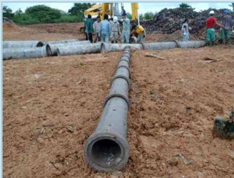
รูปที่ 45 การขยายความยาวของท่อแขนงจากข้อต่อระหว่างท่อเมนและท่อแขนง
