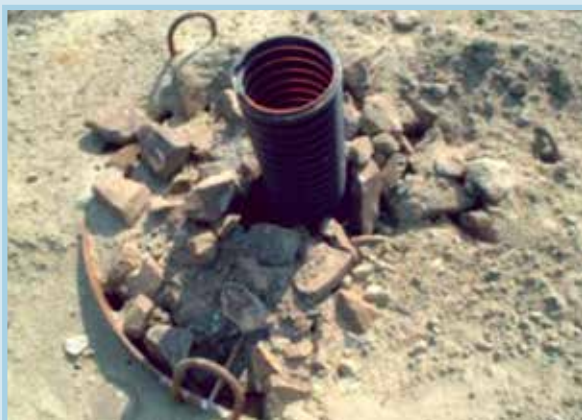
รูปที่ 69 ตัวอย่างที่ไม่ถูกต้องเนื่องจากท่อระบายก๊าซมีดินแทรกเข้าไปในท่อปอลก
