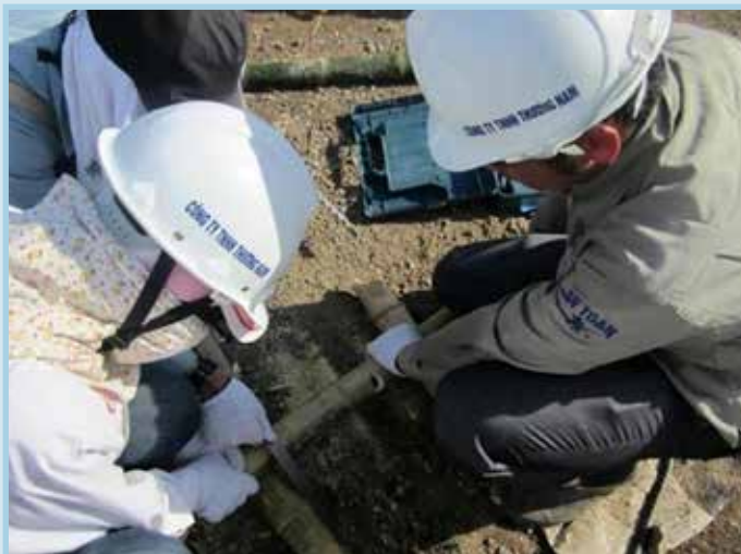
รูปที่ 50 การเจาะรูโดยรอบปล้องไม้ไผ่เพื่อให้น้ำชะขยะไหลเข้าและให้อากาศไหลผ่านรู
