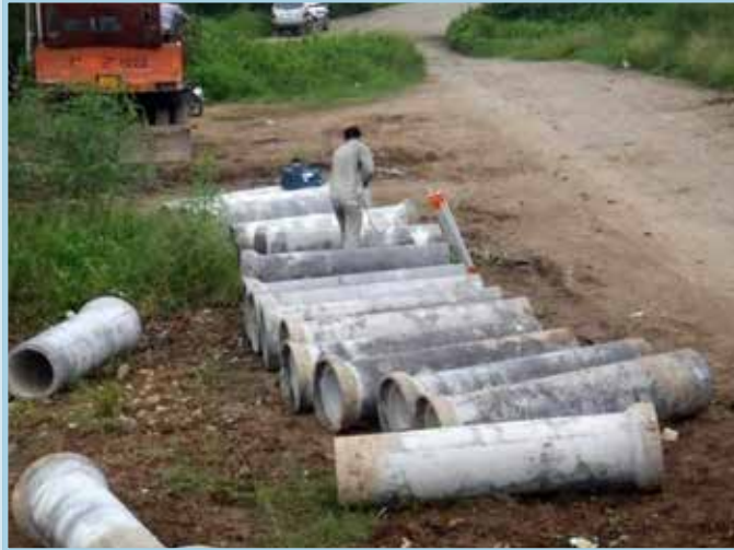
รูปที่ 29 การรวบรวมท่อซีเมนต์เพื่อใช้ในการก่อสร้างท่อรวมน้ำชะขยะ
