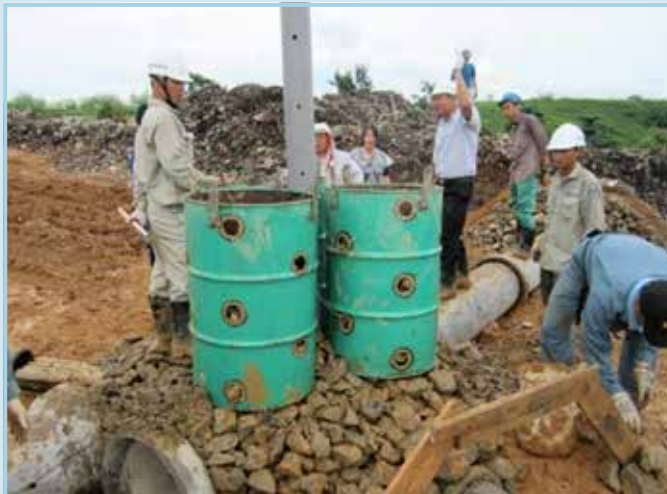
รูปที่ 52 การติดตั้งท่อระบายก๊าซในแนวตั้ง
