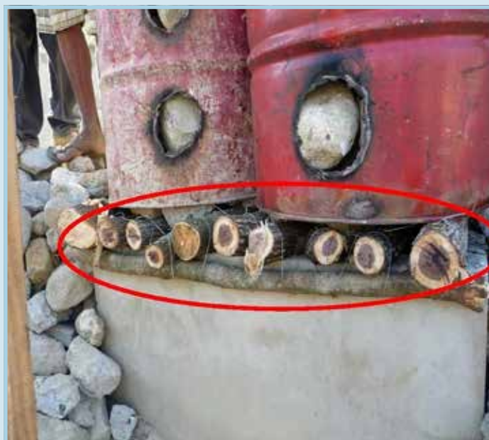
รูปที่ 47 การใช้ไม้ไผ่ท่อนหนาหรือท่อนไม้เพื่อกระจายน้ำหนักของชั้นระบายก๊าซและป้องกันมิให้เกิดความเสียหายของบ่อพัก
