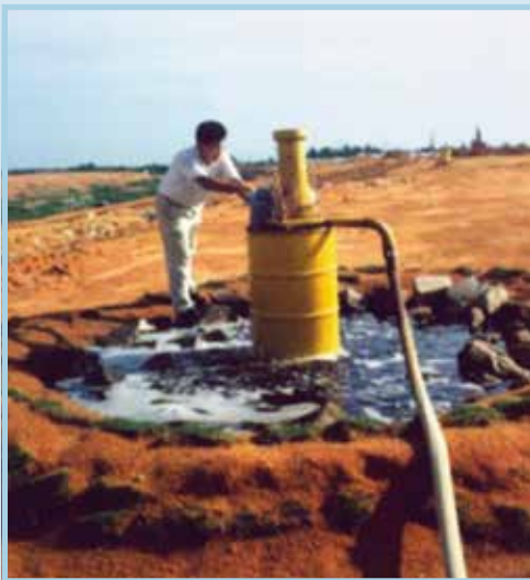
รูปที่ 23 ตัวอย่างการออกแบบระบบเวียนน้ำชะขยะกลับไปยังบ่อฝังกลบแห่งหนึ่งของประเทศมาเลเซีย
