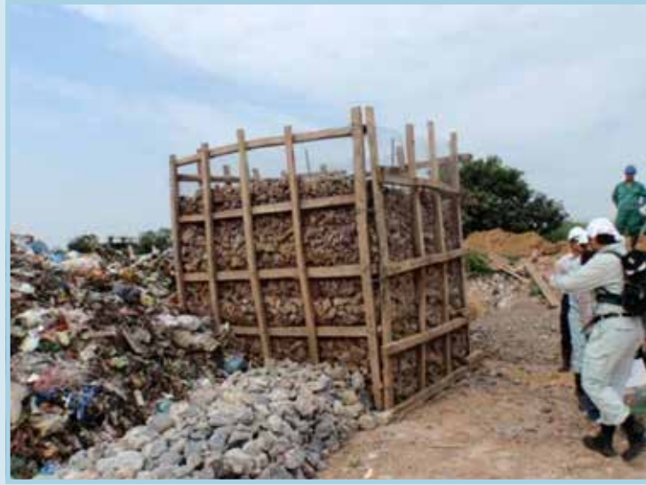
รูปที่ 58 ฐานกรองที่บรรจุด้วยหินบดย่อยสำหรับฉีดพ่นน้ำชะขยะมาบำบัดโดยการกรอง
