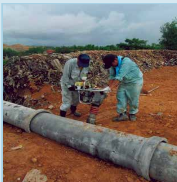
รูปที่ 39 การบดอัดพื้นดินให้แน่นบริเวณปลายท่อรวบรวมน้ำชะขยะ
