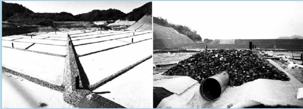
รูปที่ 12 ตัวอย่างการออกแบบท่อรวบรวมน้ำชะขยะที่ดี
