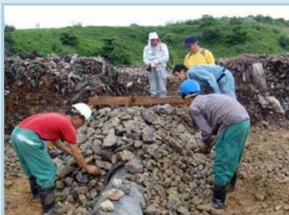
รูปที่ 43 การเกลี่ยหินบดย่อยให้เป็นลักษณะสี่เหลี่ยมคางหมูโดยแรงงานคน
