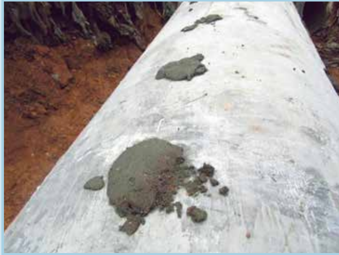
รูปที่ 33 การซ่อมแซมรอยแตกต่าง ๆ ที่เกิดจากการเคลื่อนย้าย
