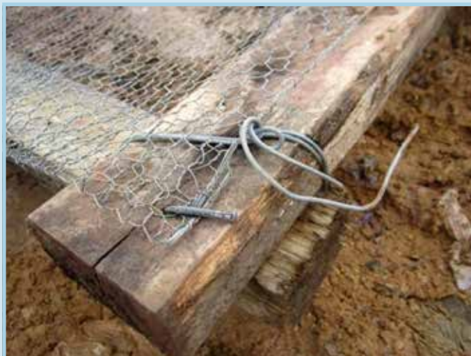
รูปที่ 56 การติดตั้งตาข่ายลวดเหนือฐานวงขอบไม้
