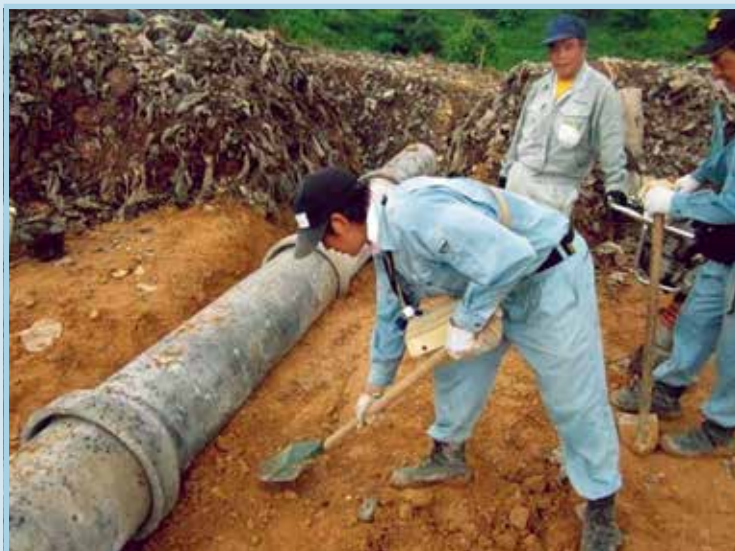
รูปที่ 38 การปรับระยะและระดับปลายท่อรวบรวมน้ำชะขยะให้มีสภาพที่น้ำชะขยะสามารถไหลได้
