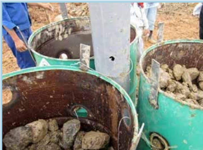
รูปที่ 53 กรูหินบดย่อยลงในถังน้ำมัน เพื่อช่วยป้องกันความเสียหายของท่อระบายก๊าซ
