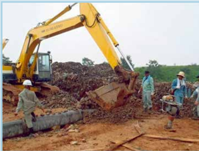
รูปที่ 42 การนำหินบดย่อยมากรูด้านข้างและด้านบนเพื่อป้องกันความเสียหายของท่อรวบรวมน้ำชะขยะ
