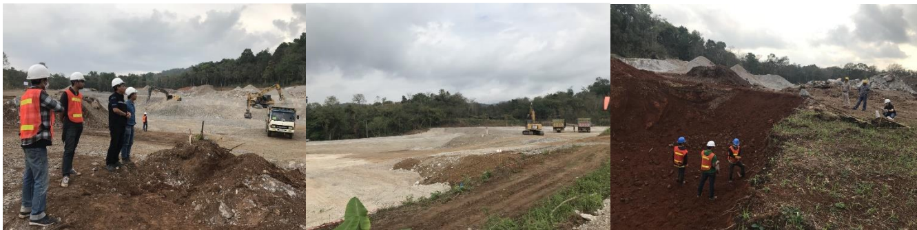
การปรับสภาพพื้นที่บริเวณหลุมฝังกลบแบบปลอดภัยและบริเวณโรงแต่งแร่
