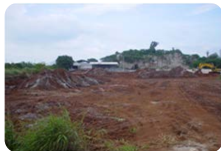
รูปที่ ๑๑-13 การขุดดินปนเปื้อนไปกำจัด
