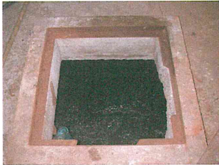
ถังเติมอากาศ
