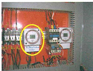
หมายเลข 1 สำหรับควบคุมการทำงานของ เครื่องสูบน้ำเข้าระบบ
