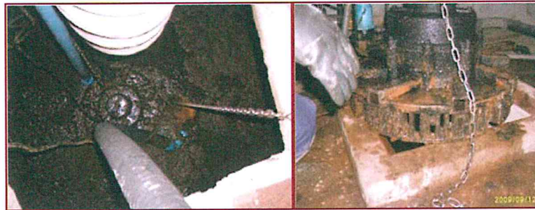
ตรวจสอบบำรุงรักษาเครื่องเติมอากาศแต่ละตัว
