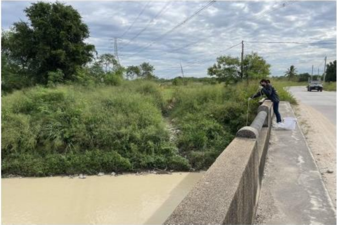
จุดที่ 5 สะพานหนองน้ำเย็น
