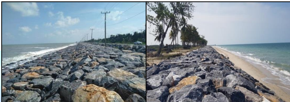
รูปที่ 4 การก่อสร้างกำแพงหินทั้งป้องกันการกัดเซาะชายฝั่งในพื้นที่กลุ่มน้ำปากพนัง
