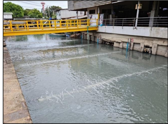
รูปที่ 2 ระบบบำบัดน้ำเสียแบบ Biological Contact Oxidation (BCO)
