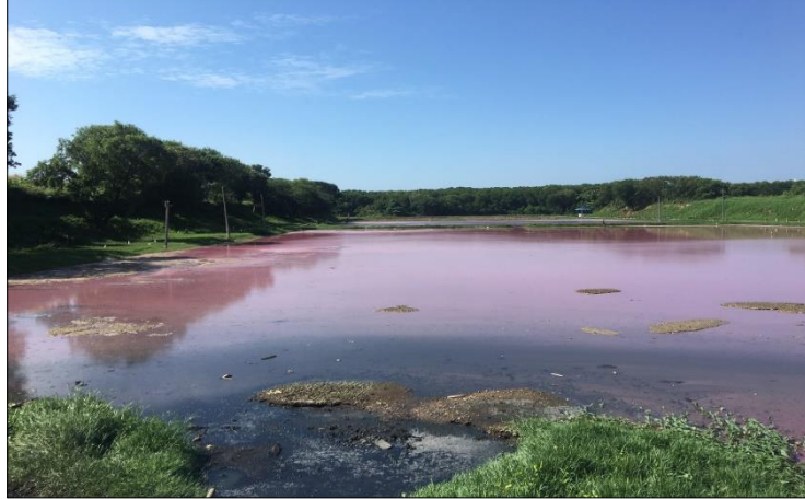
รูปที่ ๔ น้ำเสียในบ่อบำบัดมีสีชมพู
