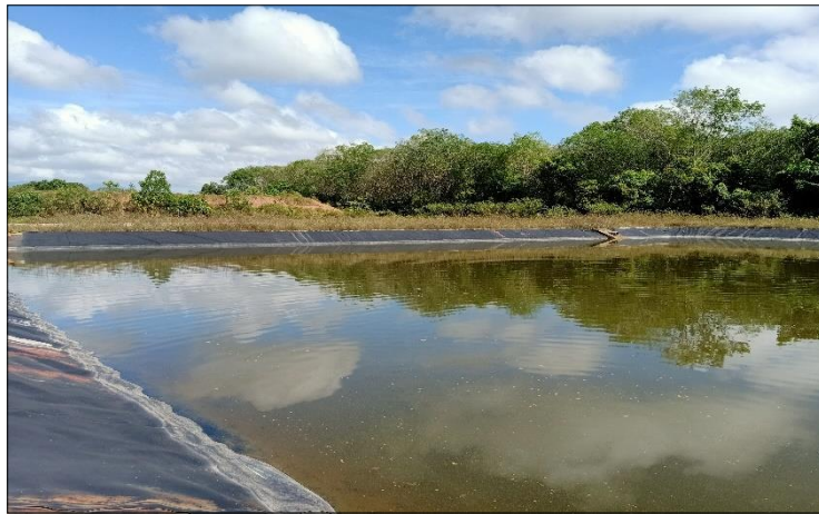
รูปที่ ๓ บ่อบ่ม (Maturation Pond)
