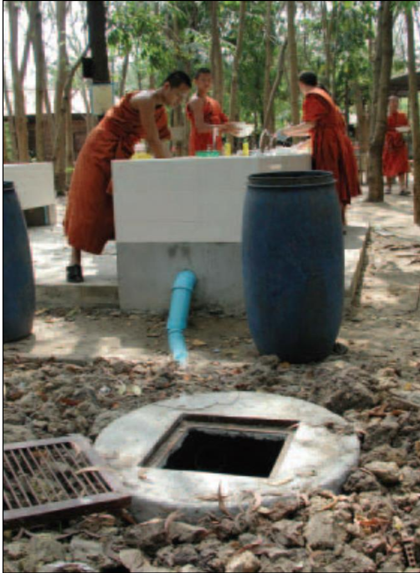
การต่อท่อน้ำเสียจากที่ล้างภาชนะสู่บ่อดักขยะ แบบใช้วงขอบซีเมนต์
