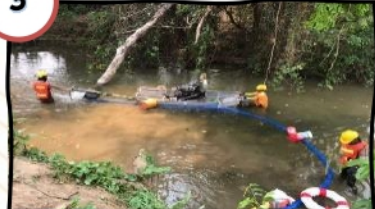
ขุดลอกด้วยการดูดตะกอน ใช้ระยะเวลาประมาณ 9 เดือน
