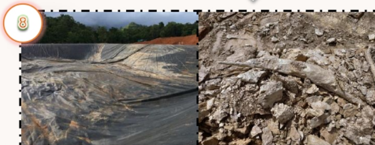
8 เมื่อแล้วเสร็จในทุกขั้นตอนดินปนเปื้อนและกากทางแร่จะกลายเป็นก้อนแข็งจากนั้นทำการปิดคลุมด้วยแผ่น HDPE ซึ่งใช้สำหรับกองกากทางแร่หรือดินปนเปื้อน เพื่อป้องกันการรั่วไหลของกากทางแร่หรือดินปนเปื้อนตะกั่ว ที่บริเวณหลุมฝังกลบ
