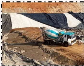
6 เมื่อปรับเสถียรเสร็จแล้ว นำมาเทลงหลุมฝังกลบแบบปลอดภัย
