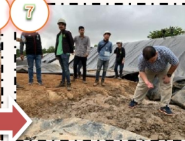
แล้วทำการทดสอบค่าความเป็นกรด-ด่าง (pH) โดยควบคุมค่า pH ให้มีค่ามากกว่า 11
