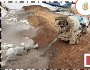
6 เมื่อปรับเสถียรเสร็จแล้ว นำมาเทลงหลุมฝังกลบแบบปลอดภัย
