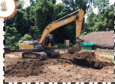
1 เริ่มขุดกากทางแร่และดินปนเปื้อนสารตะกั่วในพื้นที่
