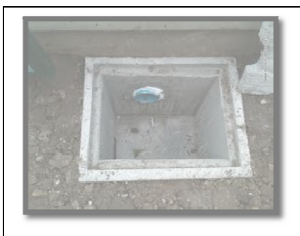
ภาพที่ ๔-๘ บ่อดักตะกอนเบื้องต้น
