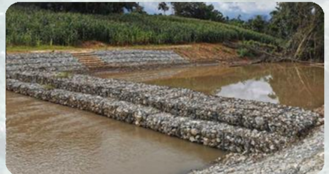
ฝายชะลอน้ำแบบกล่องลวดตาข่ายบรรจุหิน (Gabion)
