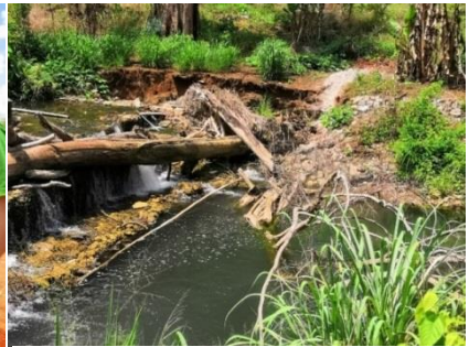
รูปที่ 5 การชำรุดของฝายดักตะกอน
