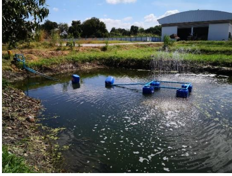
รูปที่ ๒ บ่อบำบัดน้ำเสียในโรงงานผลิตอาหารสัตว์
