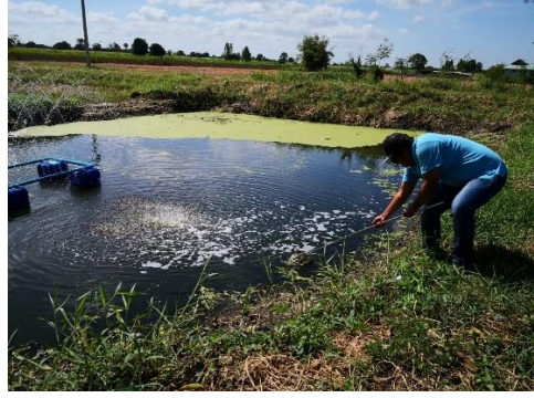
รูปที่ ๒ บ่อบำบัดน้ำเสียในโรงงานผลิตอาหารสัตว์
