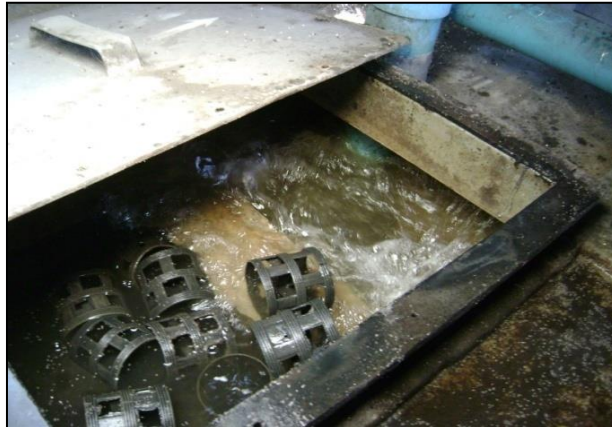
รูปที่ ๑๓ ระบบบำบัดน้ำเสียแบบบ่อกรองเติมอากาศ
