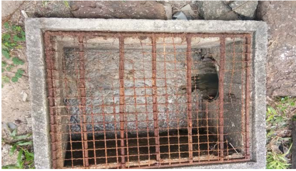
การสำรวจท่อระบายน้ำ
