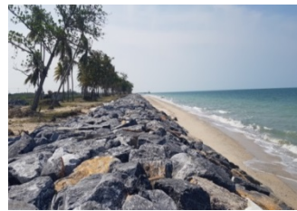
รูปที่ 3 การก่อสร้างกำแพงหินทิ้งป้องกันการกัดเซาะชายฝั่งในพื้นที่ลุ่มน้ำปากพนัง
