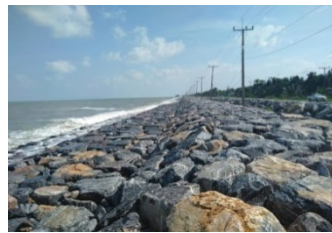
รูปที่ 3 การก่อสร้างกำแพงหินทิ้งป้องกันการกัดเซาะชายฝั่งในพื้นที่ลุ่มน้ำปากพนัง
