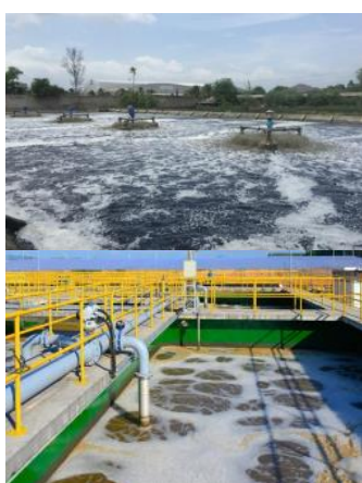
ระบบบำบัดแบบตะกอนเร่ง
