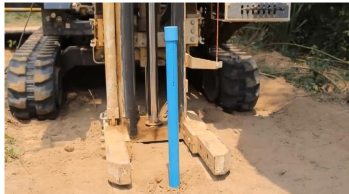
รูปที่ ๕ การเจาะสํารวจ เก็บตัวอย่างน้ำ สํารวจบ่อสังเกตการณ์
