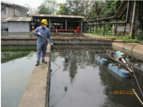
บ่อพักน้ำทิ้งรวมก่อนระบายลงสู่ระบบบำบัดน้ำเสีย
