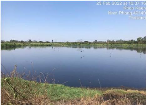
บ่อบำบัดน้ำเสียบ่อสุดท้าย
