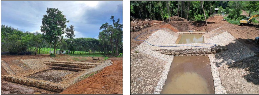
รูปที่ 5 ฝายดักตะกอนเดิม (KC4) ที่ได้รับการซ่อมแซมแล้วเสร็จ
