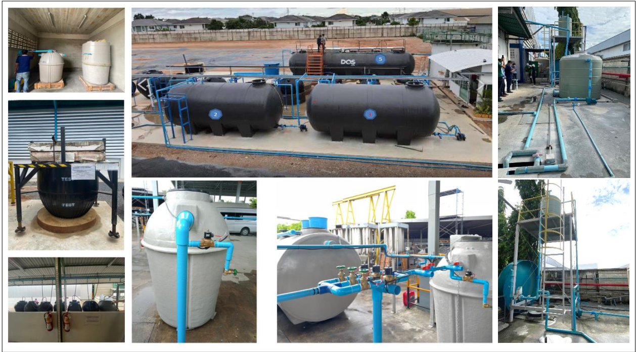
รูปที่ 3 การติดตั้งอุปกรณ์สำหรับใช้เป็นสถานที่ทดสอบประสิทธิภาพถังบำบัดน้ำเสียสำเร็จรูป
