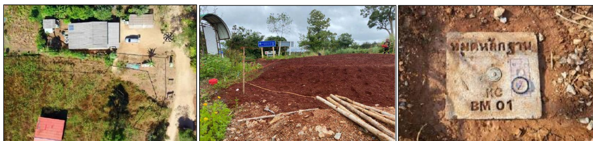
รูปที่ 1 การสำรวจพื้นที่เพื่อจัดทำแนวเขตและรั้วชั่วคราวบริเวณพื้นที่ดำเนินงานฟื้นฟู และจัดทำหมุดหลักฐาน
