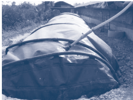
รูปที่ 8 ตัวอย่างป่อก๊าซชีวภาพสำเร็จรูปขนาดเล็ก (Package Biogas)
