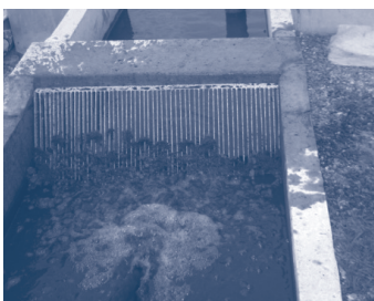
ตะแกรงดักขยะและถังดักกรวดทราย
