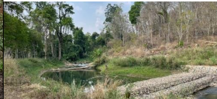
รูปที่ 3 ฝ่ายตัดตะกอน KC4
