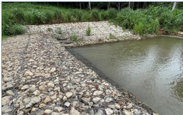
รูปที่ 5 ฝายดักตะกอน KC4
