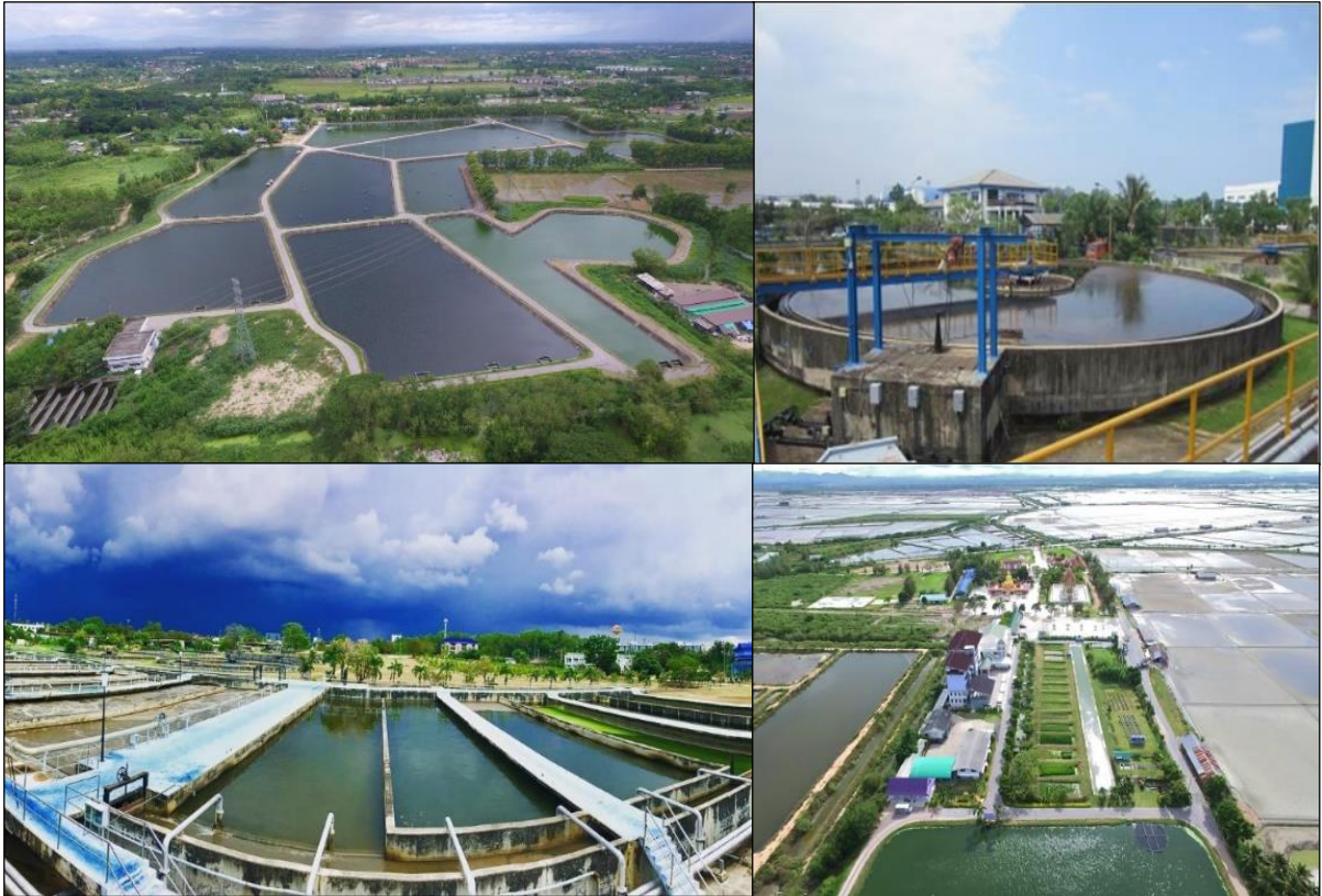
รูปที่ 2 ตัวอย่างระบบบำบัดน้ำเสียชุมชนที่ดำเนินการโดยองค์กรปกครองส่วนท้องถิ่น 4 ภูมิภาค
