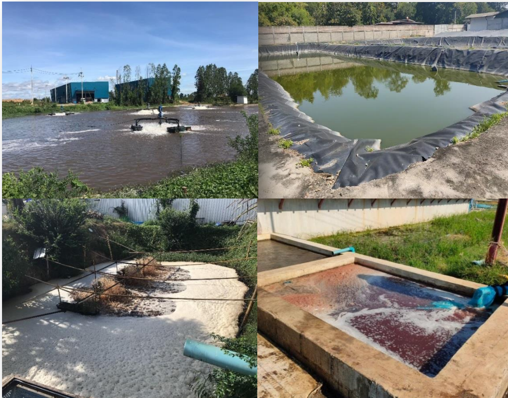
รูปที่ 2 ระบบบำบัดน้ำเสียโรงงานฆ่าสัตว์
