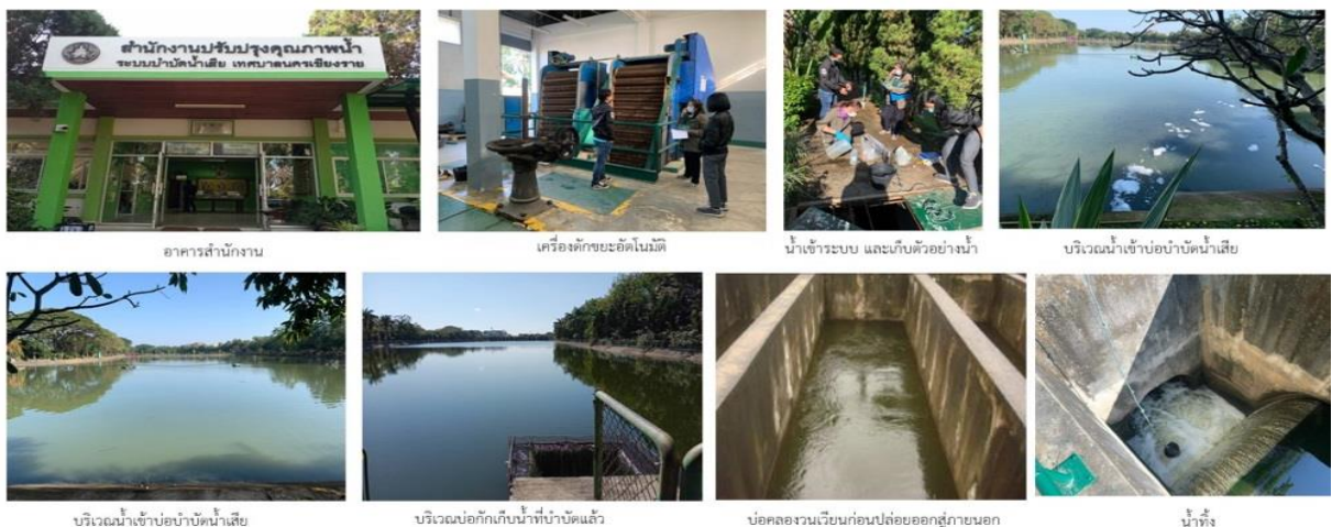
รูปที่ 1 ภาพการลงพื้นที่ติดตามระบบบำบัดน้ำเสีย
