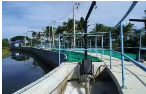
รูปที่ 7 ระบบบำบัดน้ำเสียเฉพาะจุด บริเวณอำเภopakพ่อง จังหวัดนครศรีธรรมราช
