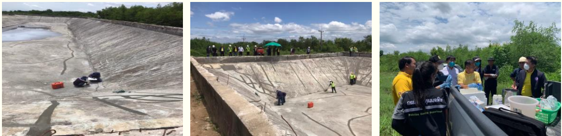
การตรวจสอบและให้ความเห็นเกี่ยวกับวิธีการตรวจสอบและซ่อมแซมบ่อฝังกลบ
