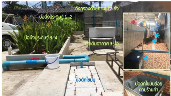
รูปที่ 1 ระบบบำบัดน้ำเสียแบบบึงประดิษฐ์ปลูกพืชในตะกร้า รพ.วัฒนา จังหวัดอุดรธานี
