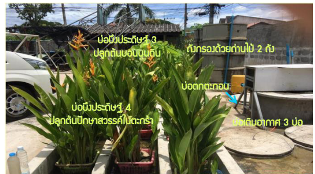
รูปที่ 1 ระบบบำบัดน้ำเสียแบบบึงประดิษฐ์ปลูกพืชในตะกร้า รพ.วัฒนา จังหวัดอุดรธานี
