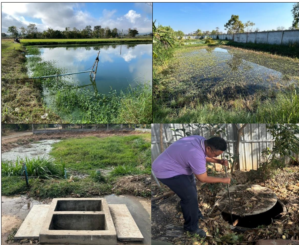
รูปที่ 2 ระบบบำบัดน้ำเสียของโรงฆ่าสัตว์ขนาดเล็ก
