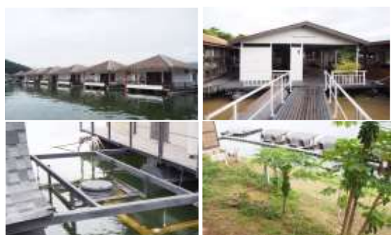
การจัดการน้ำเสียจากห้องน้ำ ห้องส้วม โดยใช้ถังบำบัดน้ำเสียสำเร็จรูป และรวบรวมมาจัดบ่มฝัง
