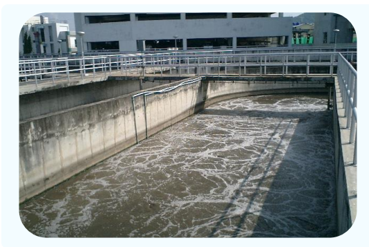
รูปที่ 22 ลักษณะระบบเติมอากาศแบบหัวฟู่
