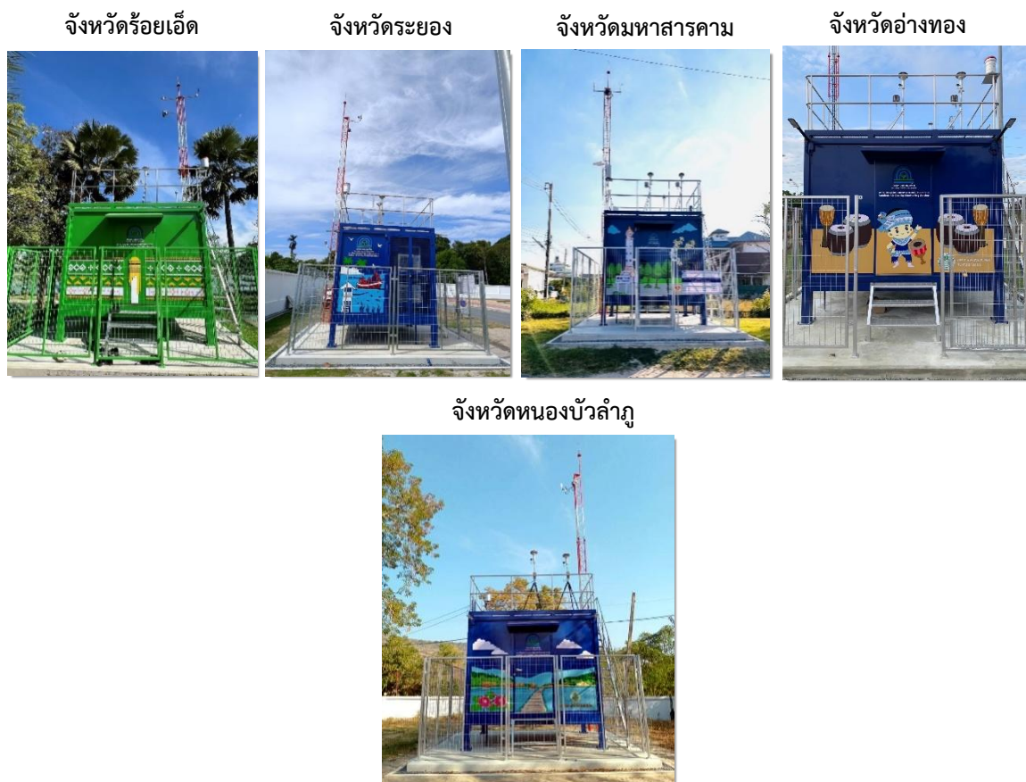
รูปที่ 4-3 สถานีตรวจวัดคุณภาพอากาศที่ดำเนินการปรับปรุงและติดตั้งเพิ่มเติม
