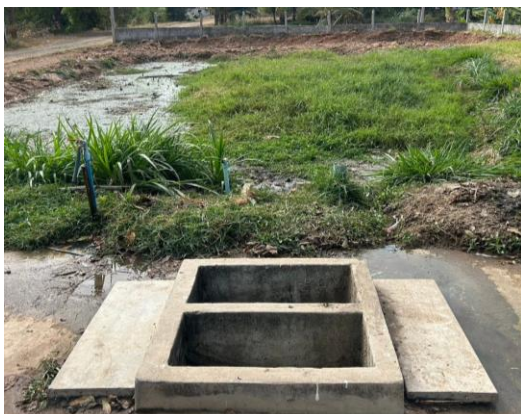
รูปที่ 2 ระบบบำบัดน้ำเสียของโรงฆ่าสัตว์ขนาดเล็ก
