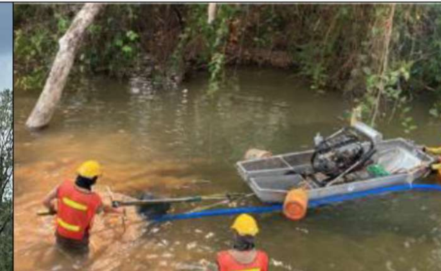
รูปที่ 2 งานขุดและขุดลอกตะกอน
